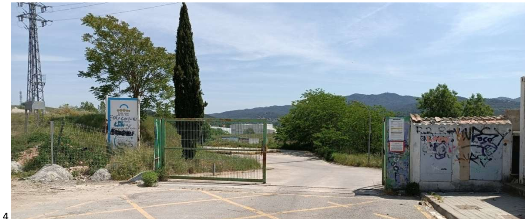
Imatge 3. Accés actual a la deixalleria municipal
