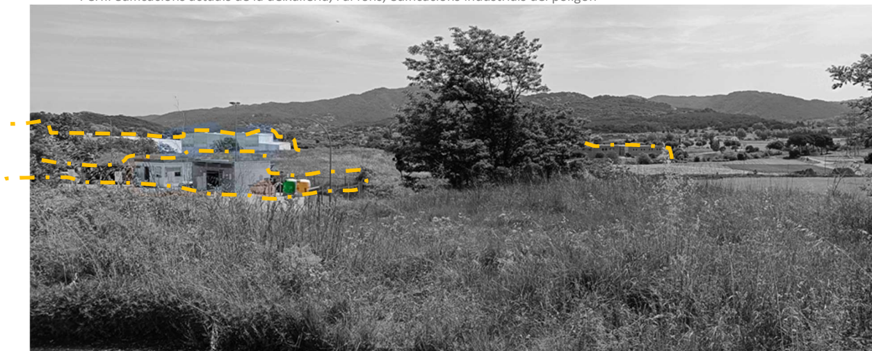
Perfil edificacions actuals de la deixalleria, i al fons, edificacions industrials del polígon
