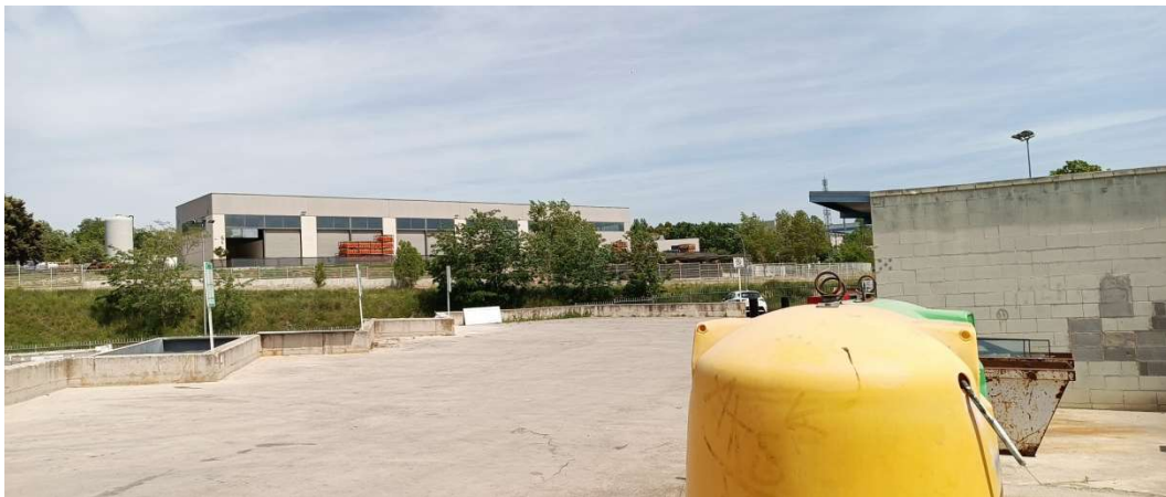
Imatge 4. Interior de la deixalleria i naus situades a l'entorn de la mateixa
