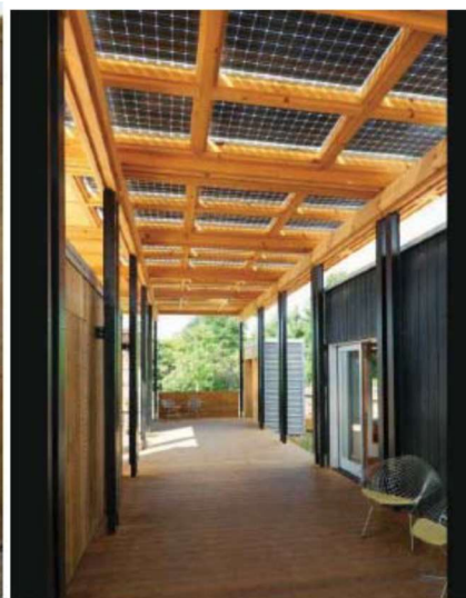
PASSADIS EXTERIOR AMB COBERTA FOTOVOLTAICA
