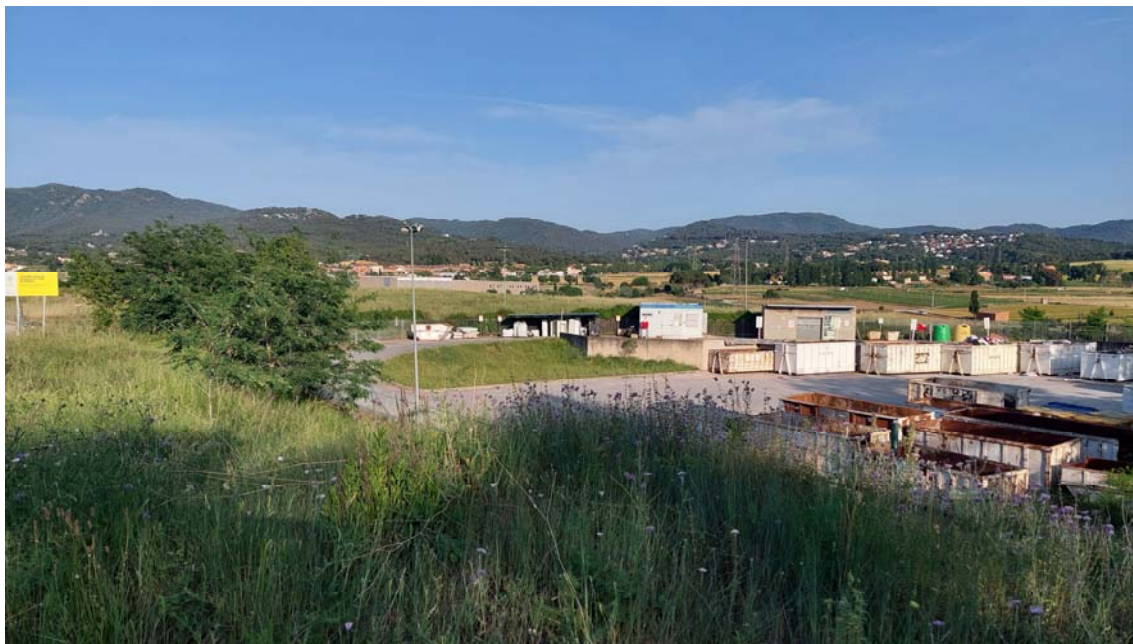
Imatge de la plataforma dels contenidors que s'ubica a una cota inferior respecte la deixalleria. També es pot observar que tot el conjunt es troba ubicat a una cota inferior que el vial.
