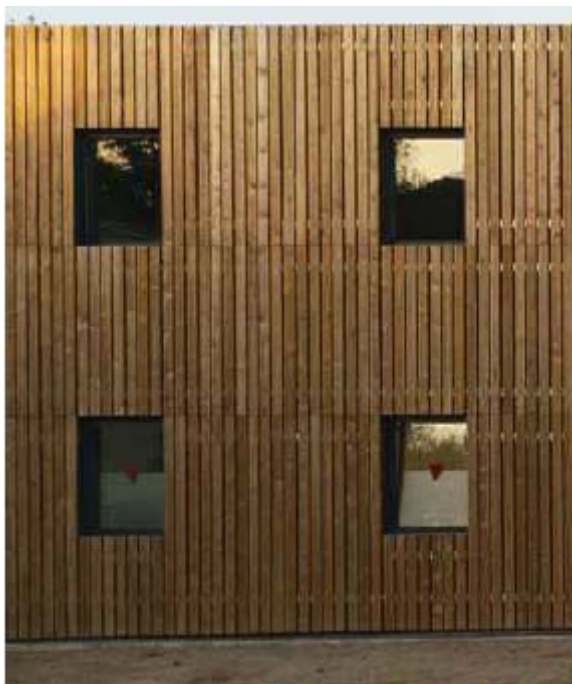
TANCAMENT DE FAÇANA AMB FUSTA
