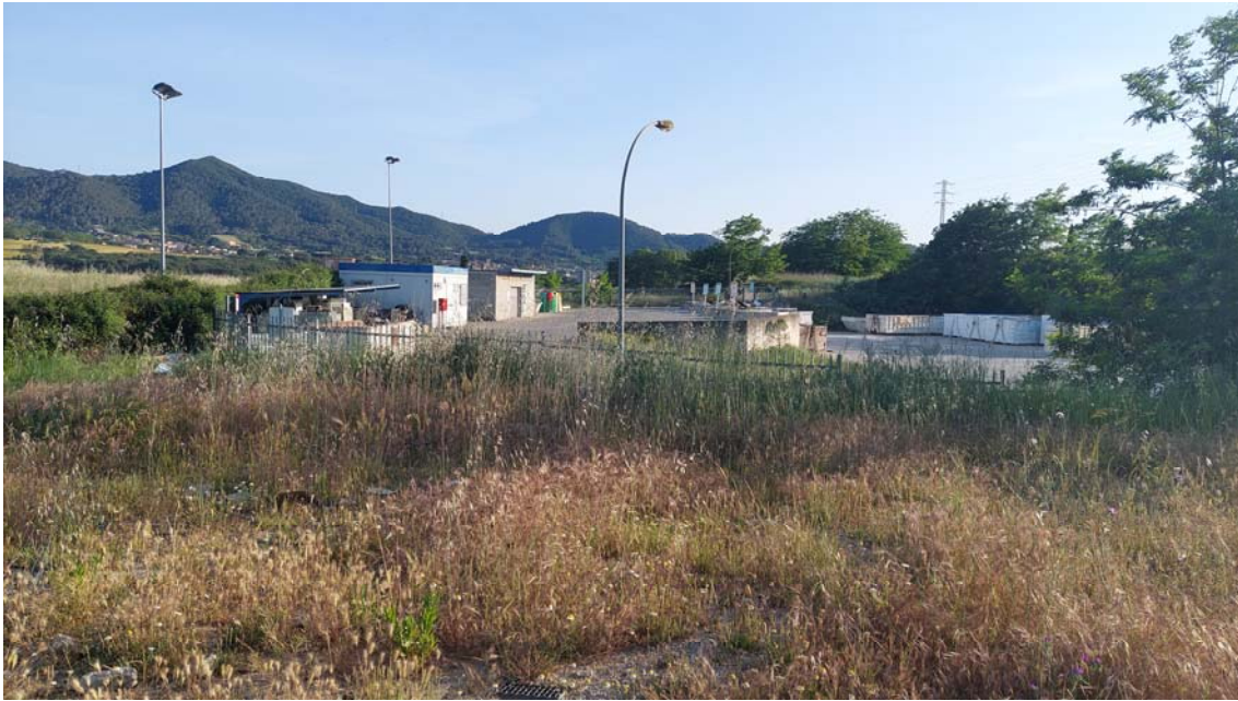
Imatge de la plataforma de la deixalleria on s'observen les edificacions existents.
