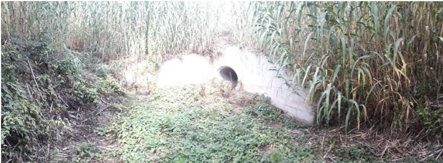
Foto 21 – Zona de recepció del pas inferior
