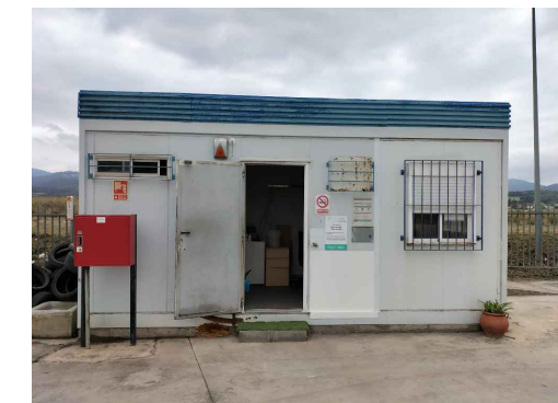
VISTA ENTRADA CASETA CONTROL
