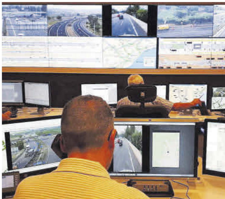
Centro de control del Servei Català de Trànsit.
