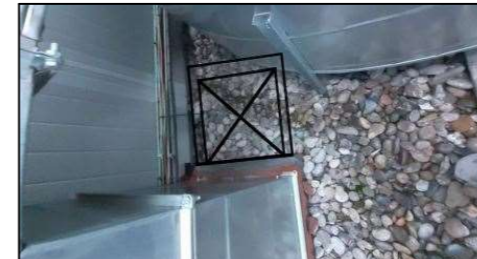
Foto coberta amb conducte de ventilació i zona per executar perforacions d'accés al pati d'instal·lacions
