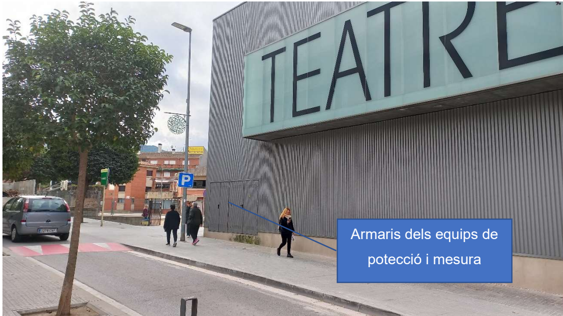
Imatge 11. Armaris d'equips de protecció i mesura
