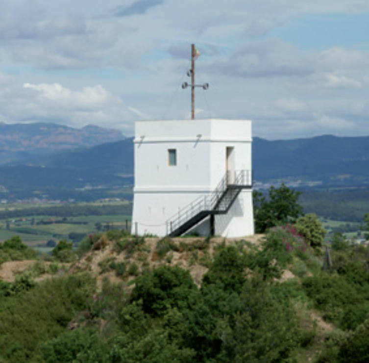
Torre de Can Bosquerons (Montornès del Vallès) Fotografia: N. Guanyabens
