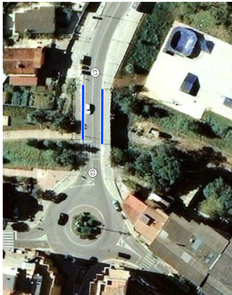
VISTA AÉREA DE L'ESTRUCTURA PO 04299
